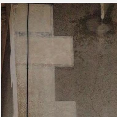
Traditionnellement, l'enduit est uniquement coloré par le sable qui le compose et qui se trouve à proximité de la construction. Le badigeon est une couche de finition très fluide et qui peut être légèrement colorée. Par souci d'économie, il s'agit principalement de colorants naturels et abondants. Pour la région, le pigment est minéral et provient du sol. Ce sont principalement les ocres. Ils peuvent être beige clairs, rosés, jaunes ou bruns pour les plus foncés.
