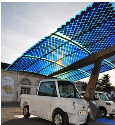
« ombrières » photovoltaïques sur un parking
