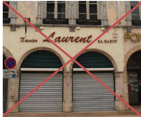
Les caissons des fermetures métalliques ne doivent pas être apparents...
