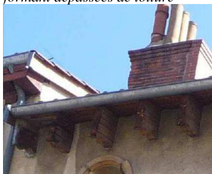
dépassée de toiture à chevrons débordant sculptés
