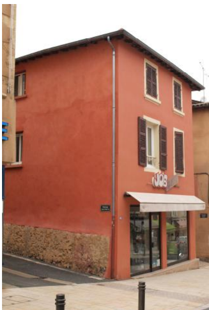
enduit traditionnel à la chaux rue Nationale
