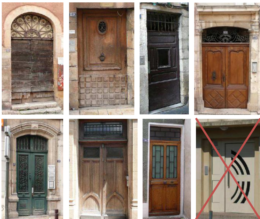
modèles de portes traditionnelles à panneau en bois en fonction des époques et des styles, et type de porte contemporaine à proscrire...
