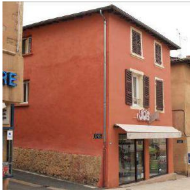
la dimension et la teinte des bannes doivent être en harmonie avec la façade...
