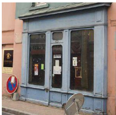
exemple d'applique menuisée
