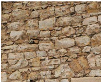
exemple de maçonnerie en « pierre dorée » destinée à être enduite...
