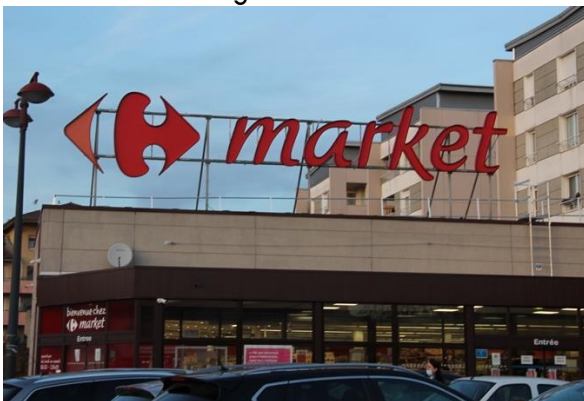
Jassans-Riottier (Enseigne illégale car structure apparente)
