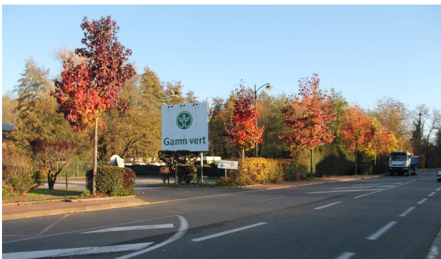
Enseignes scellées au sol (illégal surface supérieure à 6 m 2 )
