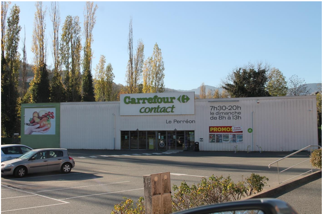
Zone commerciale - Vaux-en-Beaujolais (illégal car dépassant du mur support)
