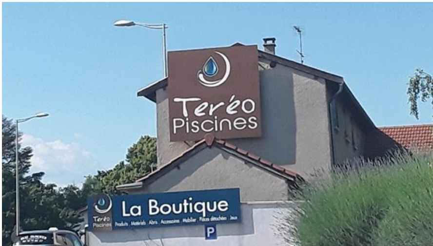
Enseignes murales illégales (dépassement du mur)
