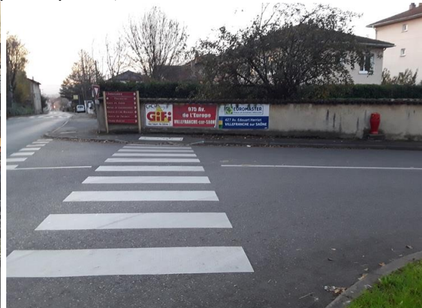
Muraux en infraction (- de 50 cm du sol)
