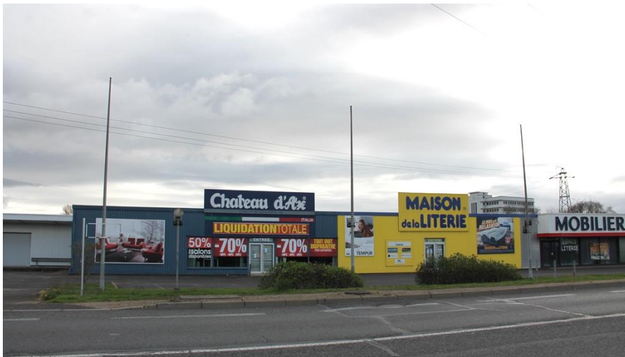
Enseignes sur toiture (illégal dépassement de la façade)
