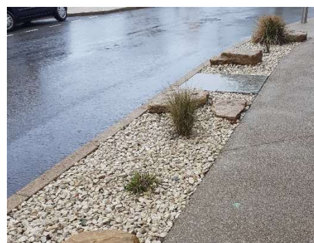
Tranchées avec aménagement de surface à Denicé
